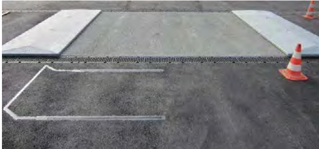
Schwellen und seitliche Abdeckung
